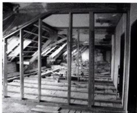
Innenausbau im Dachgeschoss
