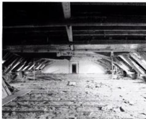
Abbrucharbeiten im Dachgeschoss
