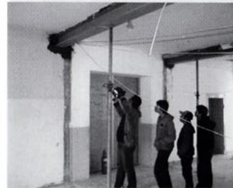
Der Einbau der Querstahlträger unter kundiger Beobachtung der zukünftigen Bewohner
